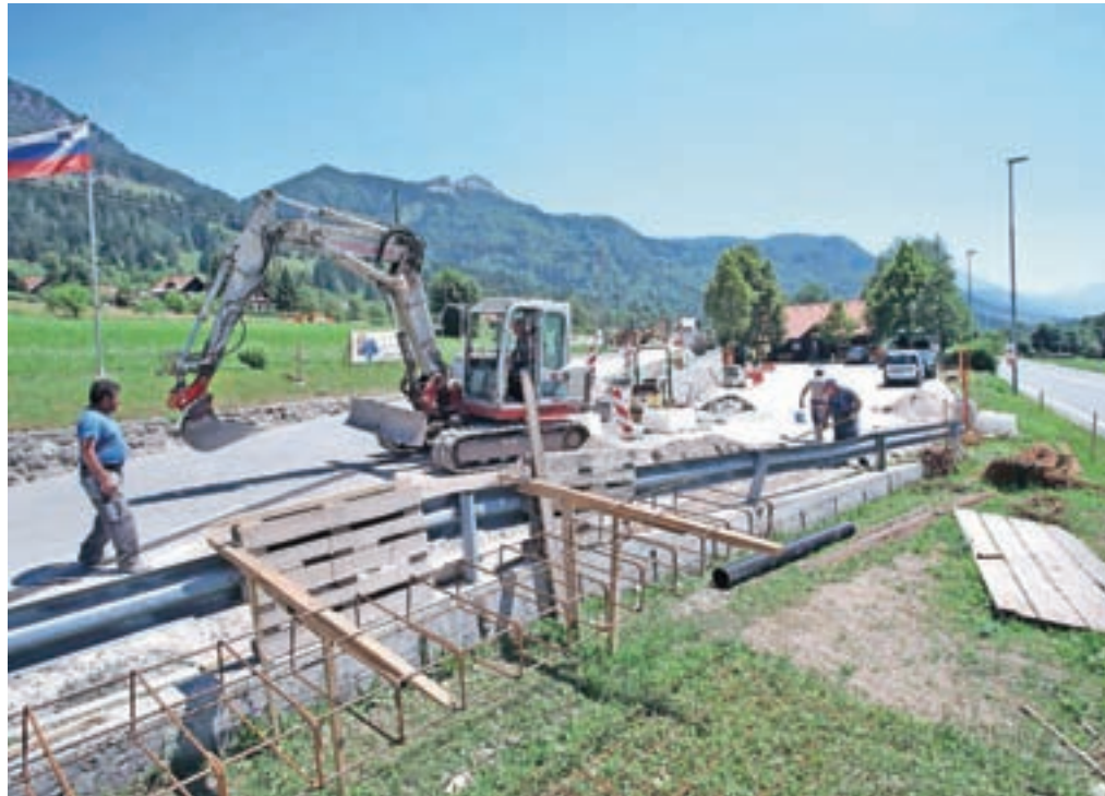
Obnova cestne infrastrukture na Dovjem je eden največjih letošnjih infrastrukturnih projektov. / Foto: Gorazd Kavčič
